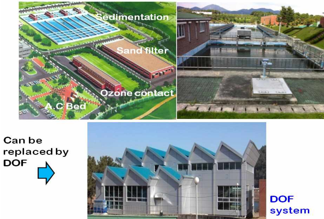
그림 2.3. 전통적인 정수처리 공정에 의해 시공된 현장 (위 사진)과 DOF 시스템 (아래 사진)에 의해 대체될 수 있는 시스템의 모습
